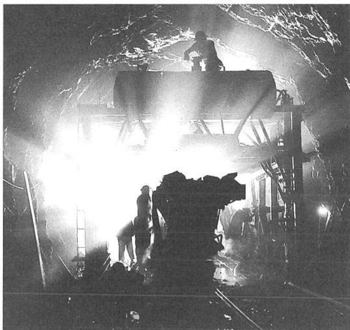
トンネル掘削工事
