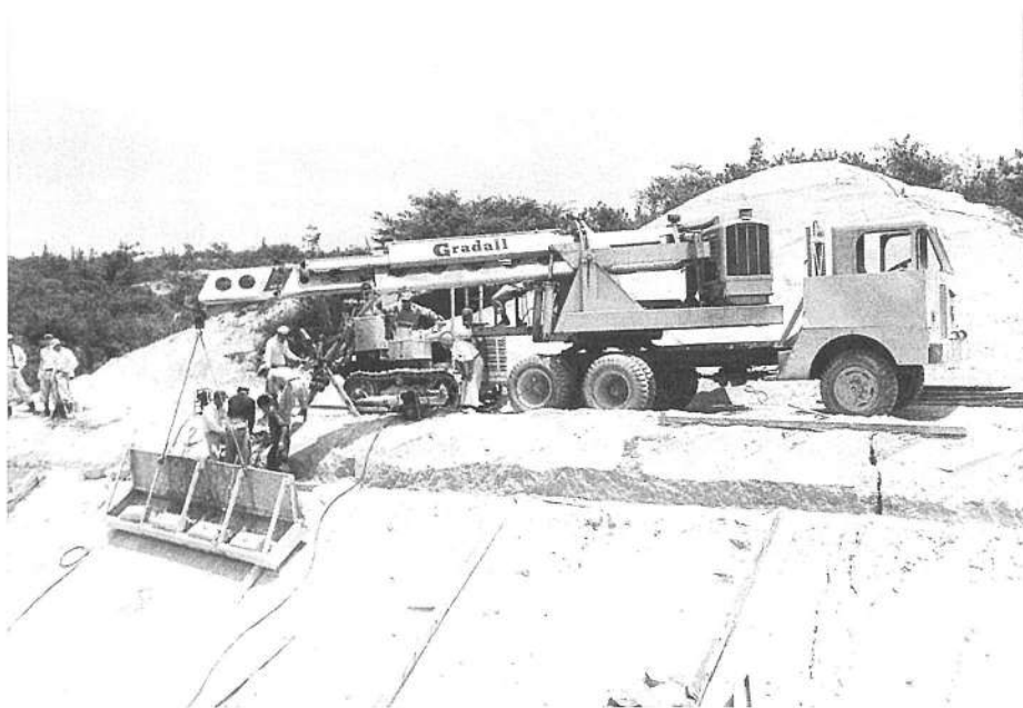
幹線水路工事
