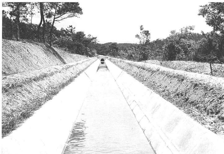
幹線水路完成
