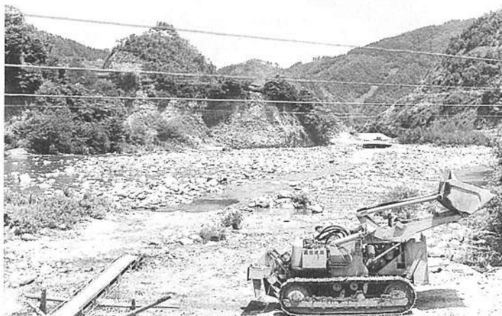
牧尾ダム着工
