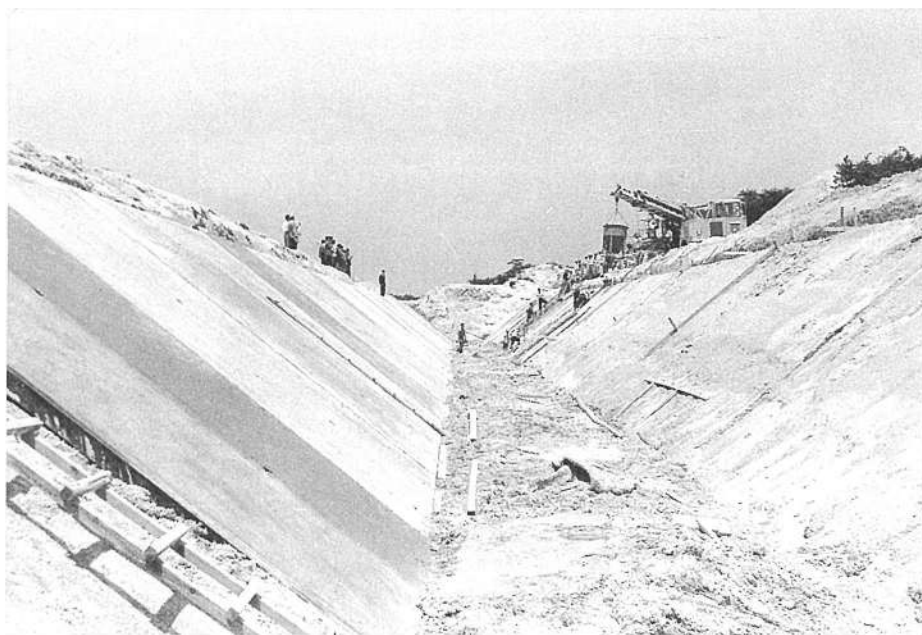
幹線水路工事も急ピッチ
