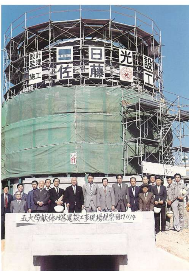
5大学献体の塔建設工事現場視察団（名大、名古屋市大、保健衛生大、愛知医大、愛知学院大）の先生方と不老会メンバー
