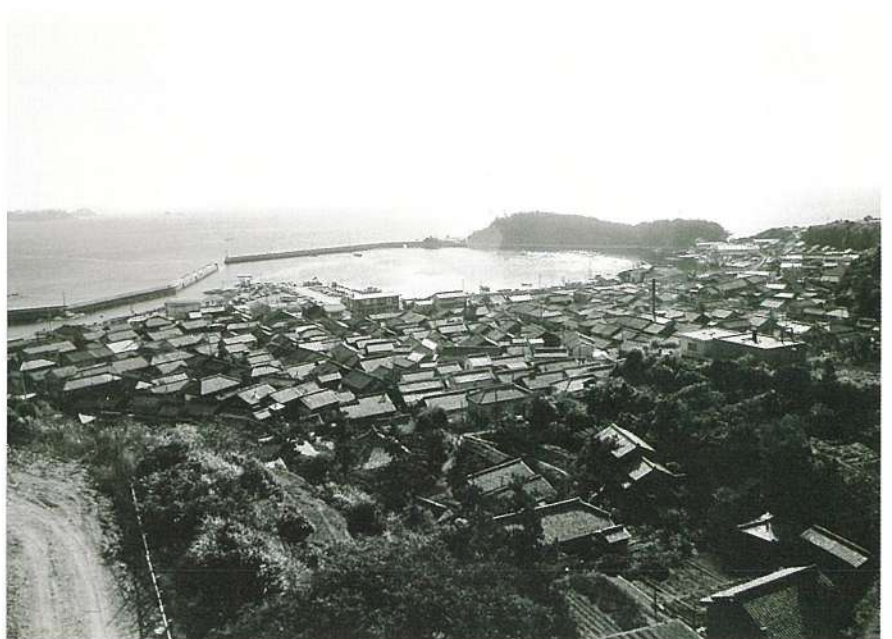
師崎港。幹線水路の終点に近いこの海岸の町は永年飲料水に苦しんできた。用水が引けるまでは浜井戸がこの町でただ一つの飲料水源であった。いまは、水道が引けている
