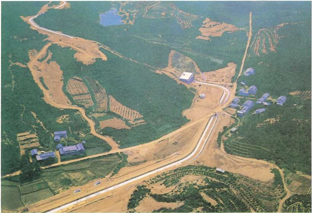
幹線の終点。内福時ポンプ場
