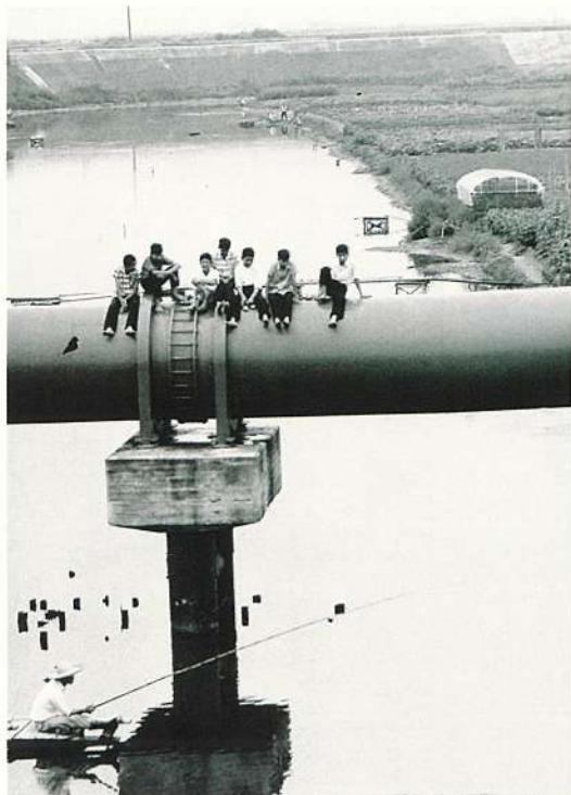
佐布里ダムより名古屋南部工業地帯に水を送る工業用送水管。完工当時はこんなのかな光景も見られたが、今では危険地区ということで、“通行禁止”になっているだろう
