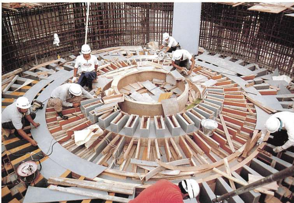
玄室天井型枠 (玉の下)工事
