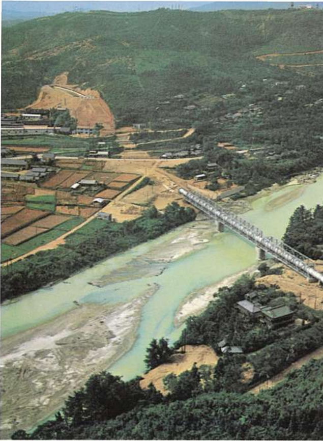
高蔵寺サイフォン(全長648メートル)と高蔵寺水路橋。トンネルを出て庄内川を鋼管橋で渡り、名古屋市守山区志段味の第1トンネルに入る
