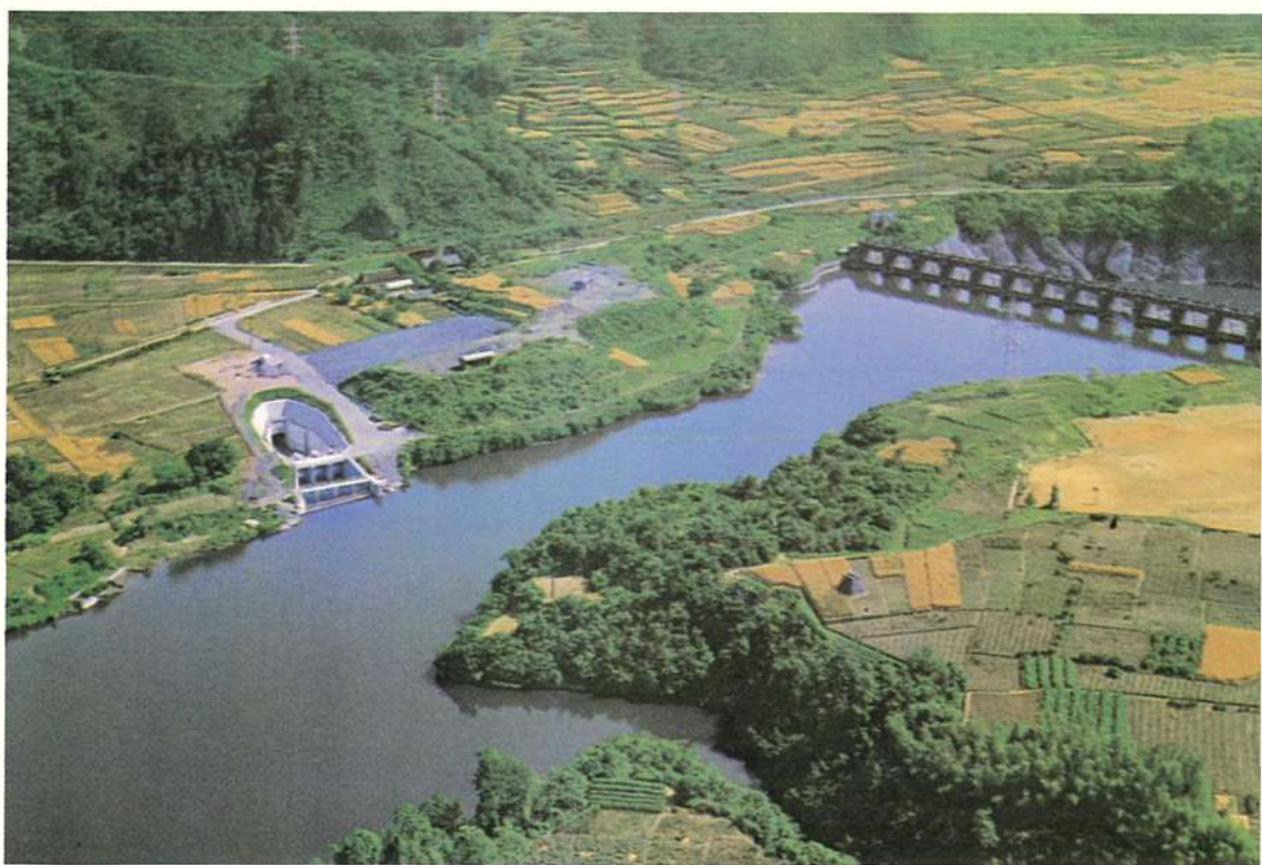
愛知用水取水口（岐阜県可見郡八百津町）。左手が兼山取水口、右手がダム
