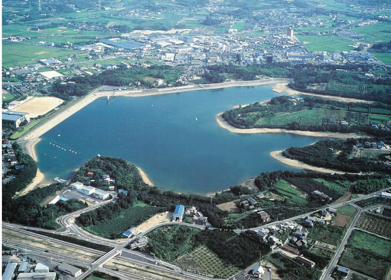
三好池（旧曲り池、西加茂郡三好町地内）ダム全景
