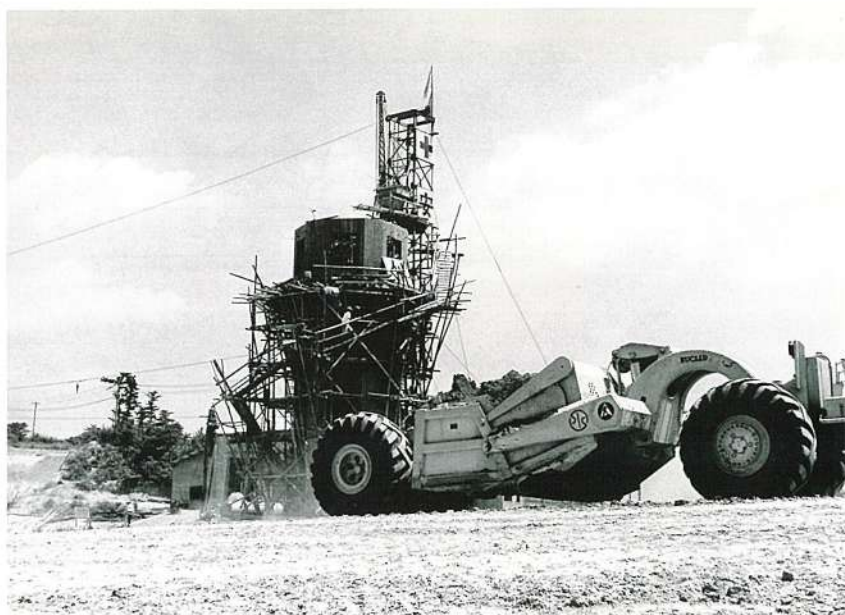
工事中の三好池ダムと取水塔
