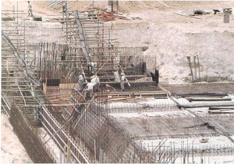
佐布里ダムの工事。農民の負担金を少しでも軽くしようと、臨海部にコンビナートの誘致を考え佐布里ダムを作ることによって、用水の水を環流させ工業用水として役立たせた
