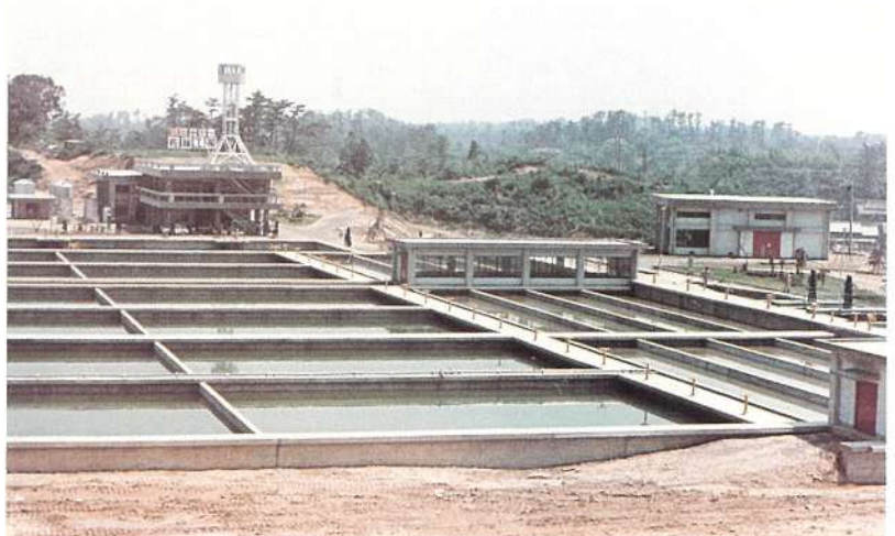
佐布里浄水場—愛知用水から送られきた水はこの水槽に入れられ、浄化して工業用水となり臨海工業地帯へ送水管を通して送られている
