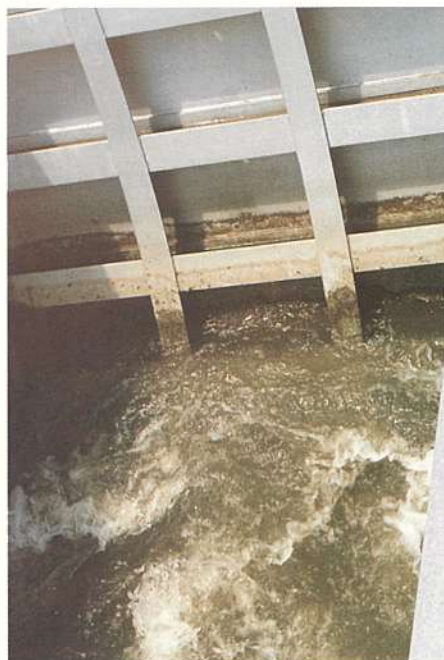
佐布里ダムの調整ゲート。流れる水量を自動的に記録する
