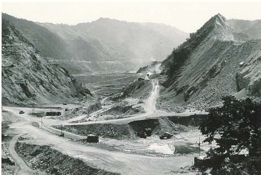
牧尾ダム工事現場（昭和33年）
